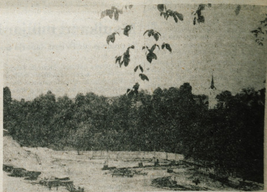
Še približno mesec dni in gradbena jama hidroelektrarne Mavčiče bo končana. Doslej so iz nje odstranili že 60.000 kubičnih metrov gramoza, zakopali pa bodo še 20 metrov globoko.
