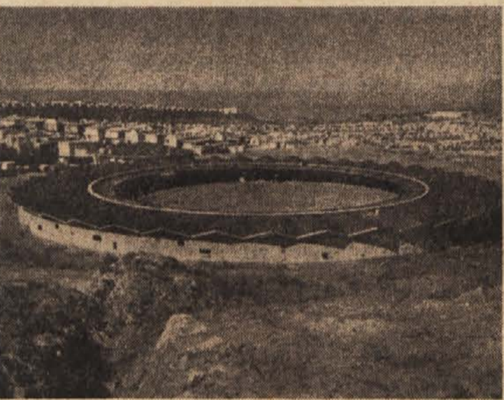
V Kaliforniji so zgradili svojevrstno šolsko poslopje. Trinajst učilnic je razporejenih v krogu, tako da sestavljajo kolobar z igriščem v sredi.
