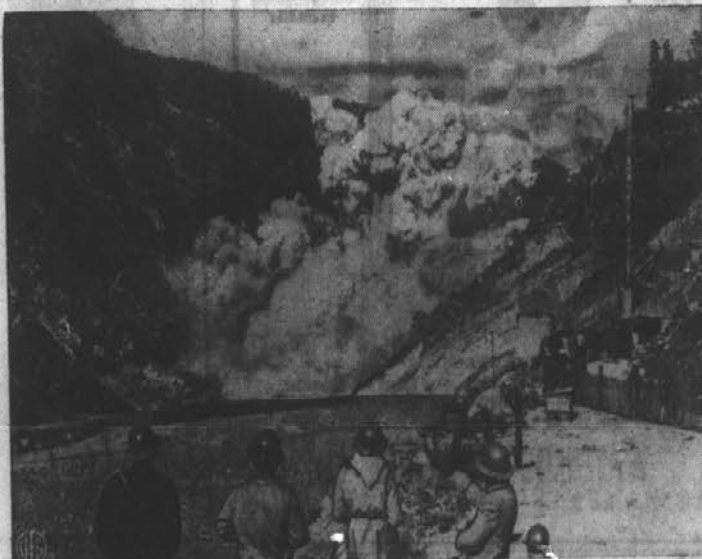
Rekordna razstrelba. — V Elizabethton, Tenn., delavci in drugi gledalci opazuje, kar izvedeni imenujejo največjo konstrukcijsko razstrelbo. Krog 210 ton najmočnejšega razstreljiva je bilo zažganega naenkrat, da bodo dobili kamenje za gradnjo TVA Watauga jez, katerega nameravajo dogotoviti v letu 1949.
