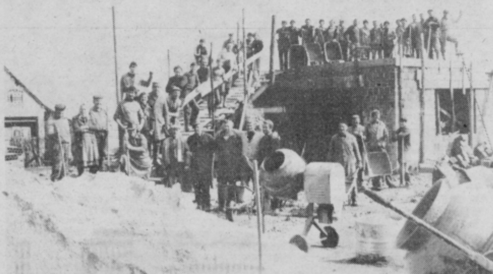
V Imenem znajo skupno prijeti za delo. Lani še prva plošča, letos pa je gasilski dom že zgrajen.
