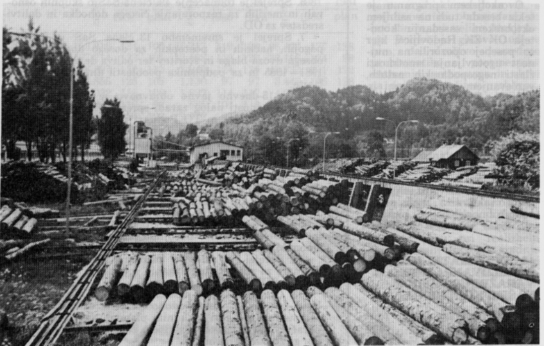
Skladišče oblovine TO Rečica pred rekonstrukcijo
