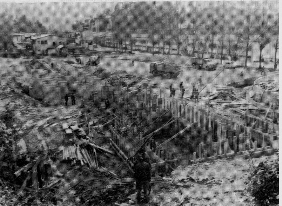
Temelji za lupilnik, čelilnik s sortirno linijo so gotovi (foto Ažman)
