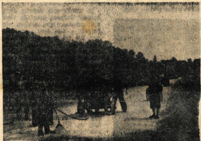
Asfalterji na cesti Novo mesto—Smednik
