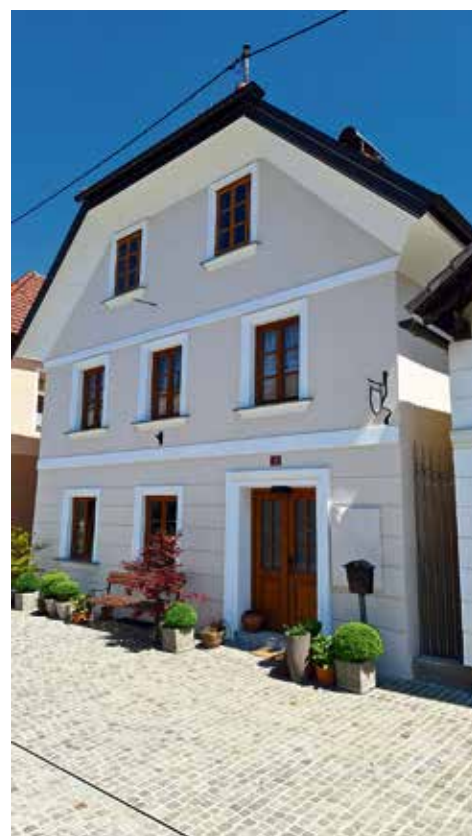
Obnovljena glavna fasada na hiši Mestni trg 14. Foto: Dušan Štepec
