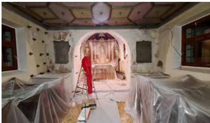
Injektiranje slavoločne stene v cerkvi sv. Andreja v Hrastovem Dolu. Foto: Dušan Štepec
