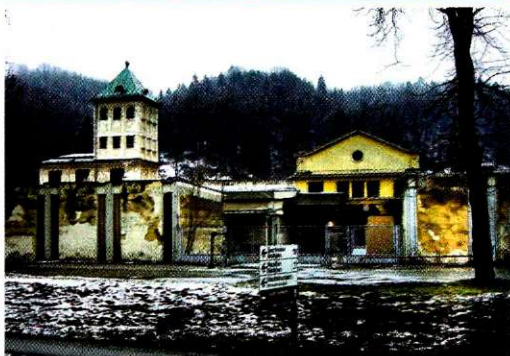
Nekdanje mestne klavnice ob Mesarski ulici: ta lokacija je bila praktično že pred realizacijo, a se je zataknilo pri Gradu su Jesenice in ministrstvo za šolstvo.
