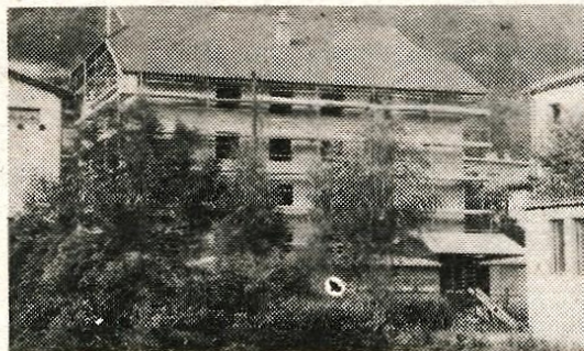
Na Jesenicah gradi SGP Sava nov samski dom za delavce Komunalnega podjetja Kovinar. V njem bo prostora za okoli 100 delavcev. Graditev bo veljala okoli 5 milijonov dinarjev. — Foto: B. B.
