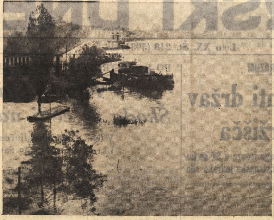
Sava je začela upadati, toda pristanišče v Slavovskem Brodu je bilo predvčeršnjim še vedno nekoliko ogroženo. Voda je narasla na 712 centimetrov, do kritične točke pa je le še manjkalo poldrugi meter
