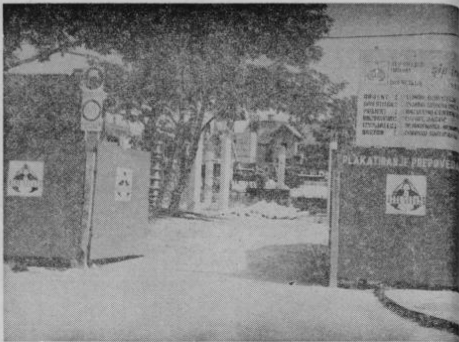
Na gradbišču novega dijaškega doma v Celju
