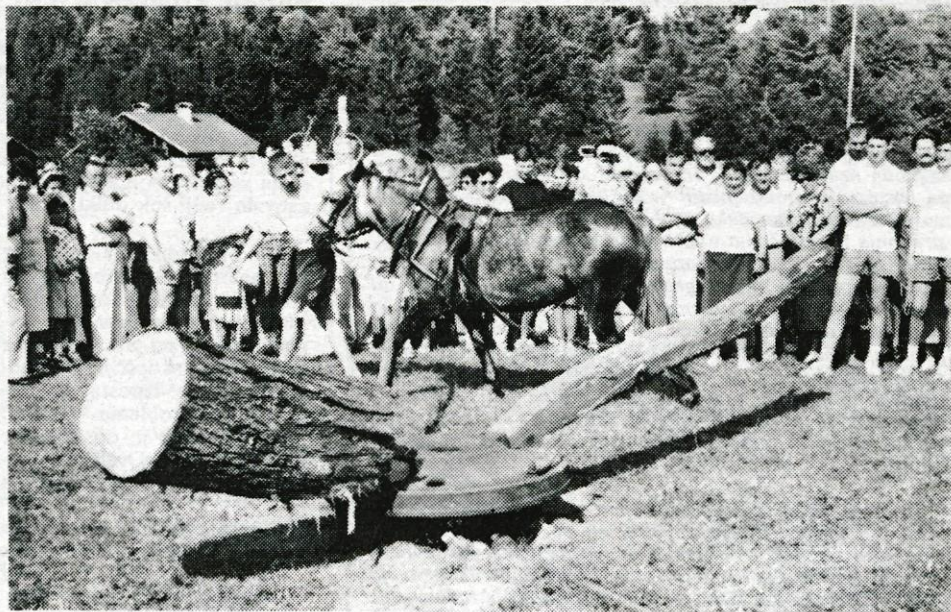
Ko še ni bilo elektromotorjev, so kmetijske stroje pogánjali z gepljem.
