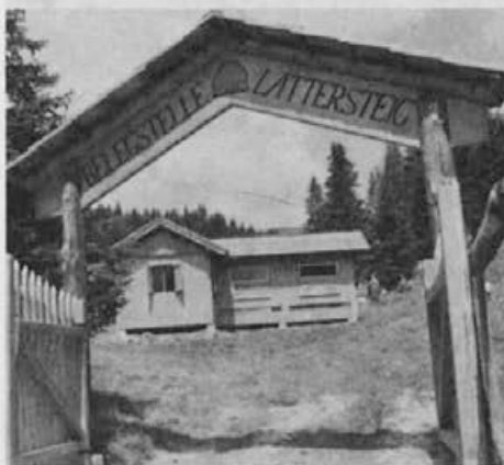
Vhod v plemenilno postajo Lattersteig. F. Lakner
