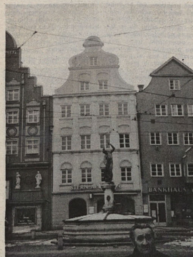
Augsburške hiše kot kulise. Je sploh kaj za njimi?
