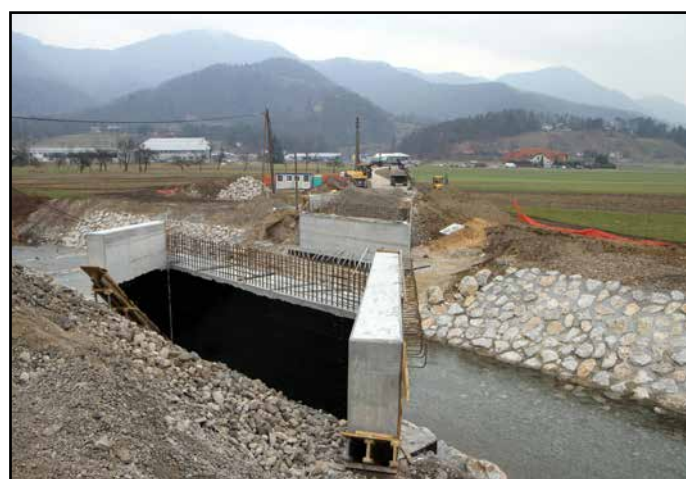
Gradnja mostu in dovozne ceste do poligona AMZS
