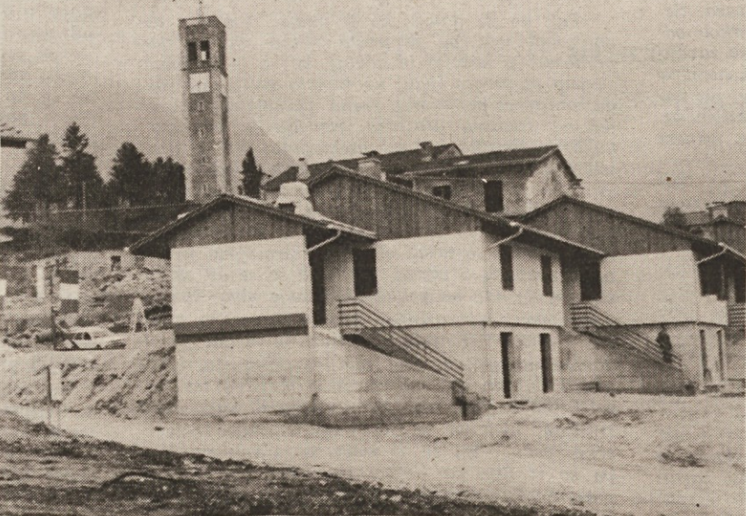
Kmalu po dneh groze so se začela obnovitvena dela, ki še trajajo, vendar je precej rezultatov že vidnih
