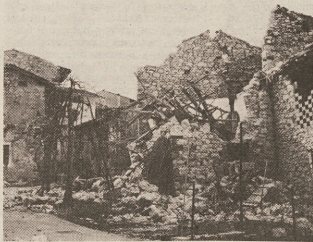
V trenutku je bilo konec večletnega truda, hiše so se porušile
