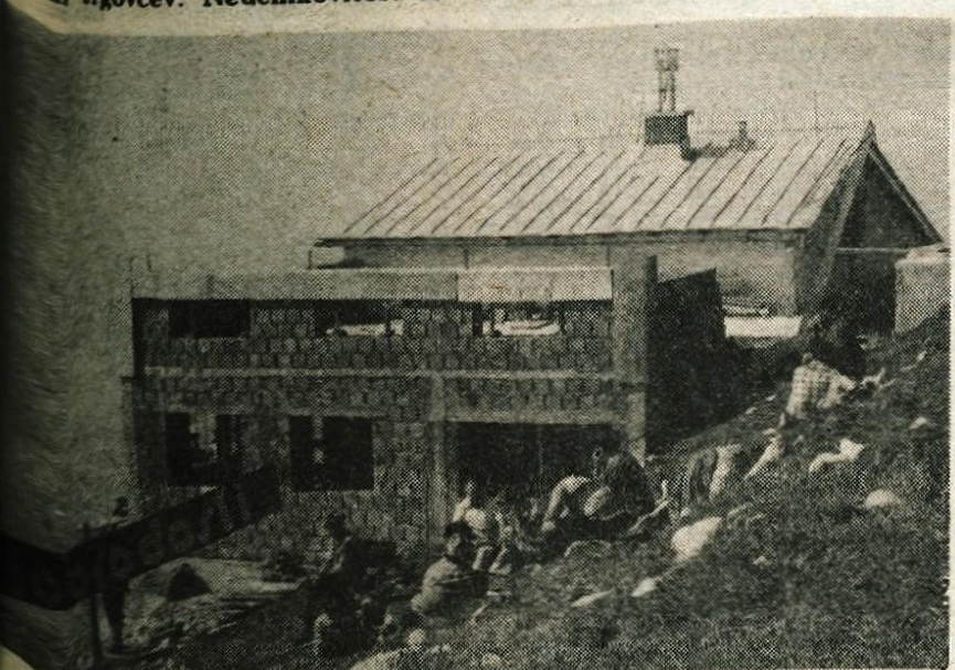
Prizidek Prešernove koče na Stolu – Člani planinskega društva Javornik-Koroška Bela, ki oskrbujejo Prešernovo kočo na Stolu, so s prostovoljnim delom in s pomočjo helikopterja, ki je vozil gradbeni material zgradili prizidek k Prešernovi koči na Stolu. Prešernovo kočo poleti obišče veliko planincev, tudi s sosednje Koroške, zato je bila razširitev postojanke nujna. S prizidkom bodo pridobili dvoraznino, dve sobi s skupnimi ležišči, povečali pa bodo tudi kuhinjo. – Foto: Janko Rozman
