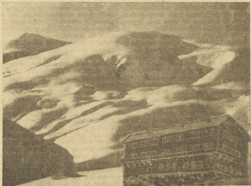
Tereni na Popovi šapki na Sar planini. Na desni je novi smučarski dom
