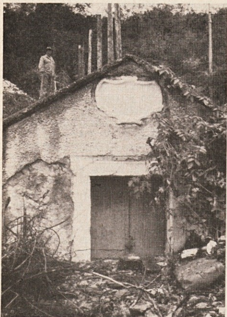
Vodohran svetoivanskega potoka, ki dobiva vodo iz podzemnega Timava
