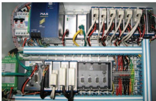
► Slika 3: Krmilni sistem, ki vsebuje V/I-enote in pogone v sistemu Compact RIO in razširjenem ohišju EtherCAT
