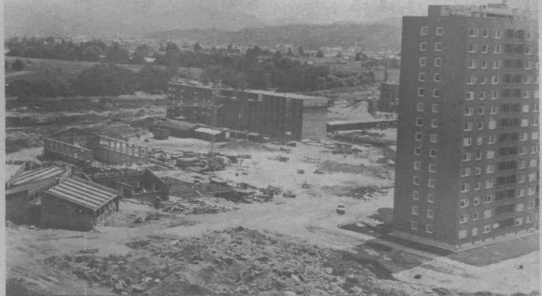
Gradnja osnovne šole v Štepanjskem naselju napreduje. Na predzadnji seji vseh treh zborov občinske skupščine pa so se delegati odločili, da se šola poveča od prvotnega načrta za 6 učilnic. Stroške za to povečanje v višini 2.316.812 din bo krila občina. (Foto: I. Gajič)
