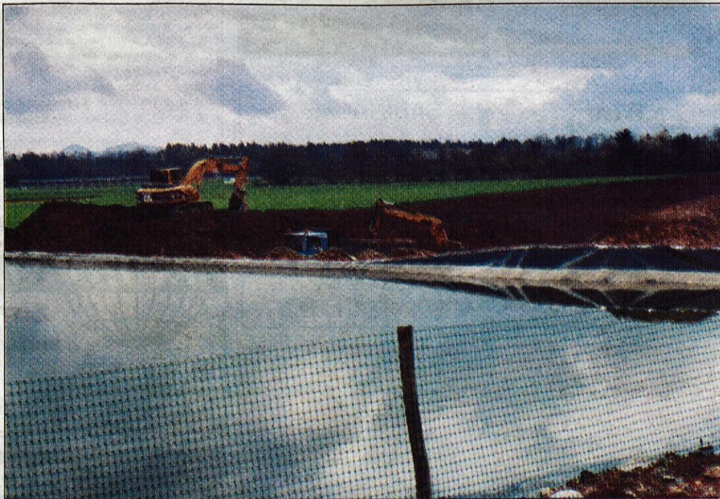
Dela na regulaciji potoka Olševnica pospešeno potekajo. Pričakujejo, da bodo konec maja že zaključena.
