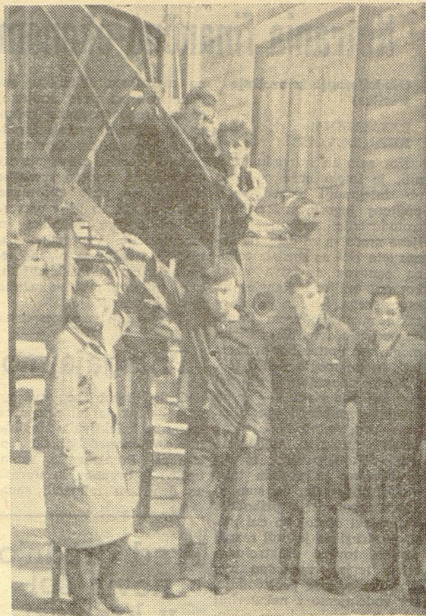
Ekipo monterjev, ki ima polne roke dela z montažo uvozne in domače opreme
