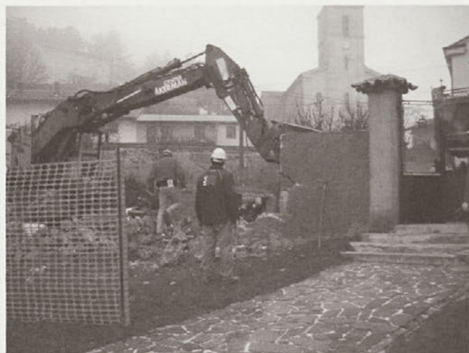
Dela na gradbišču mrliške vežice so se končno začela - star zid, preko katerega mrliška vežica ni mogla celih 13 let, je končno porušen ...
