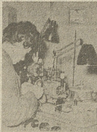
Navijanje spiral za žarnice
