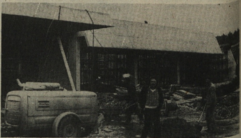
Prva plošča hotela v Strunjanu je zabetonirana
