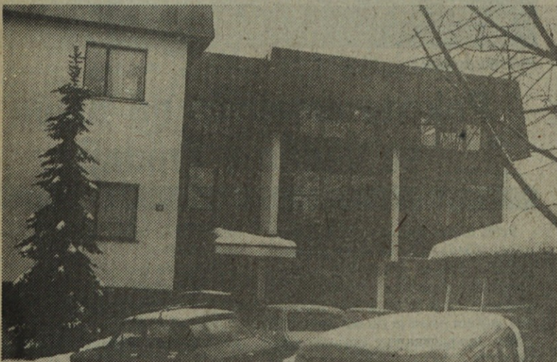
Prizidek upravni stavbi za LIP Bled je končan
