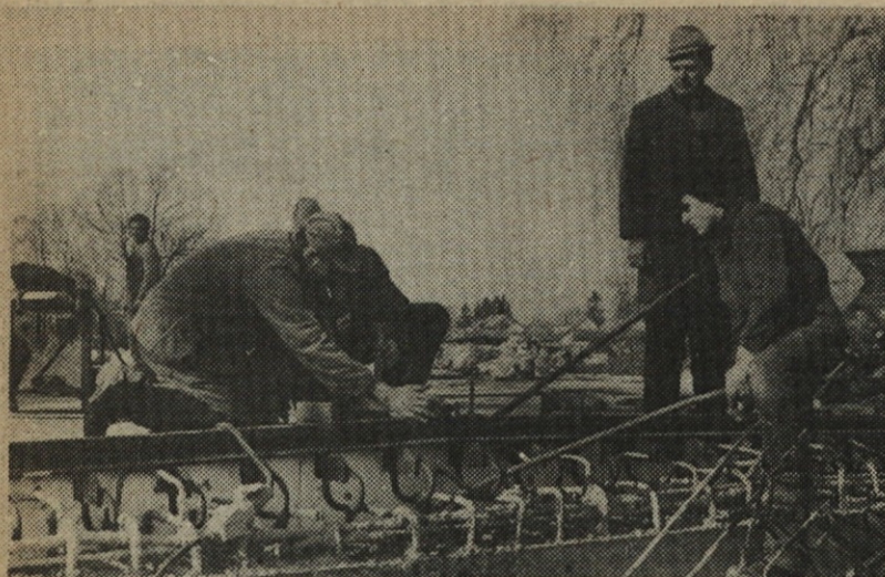
Delavci pri zaključnih delih na mostu čez Ljubljanico pri gostišču Livada
