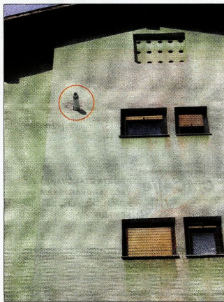
Individualni dimniki, ki je vnaprejšnje fasado bloka.
