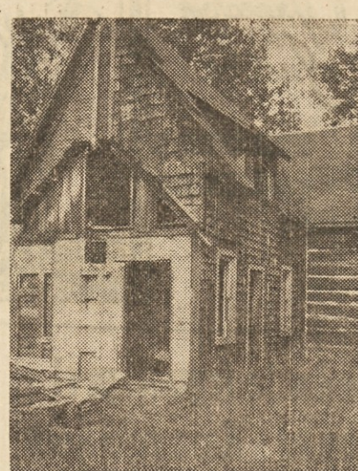
Opuščena Viljem Cardinalova hiša, grajena s stenami bivše Baragove cerkve v L'Ansu.
