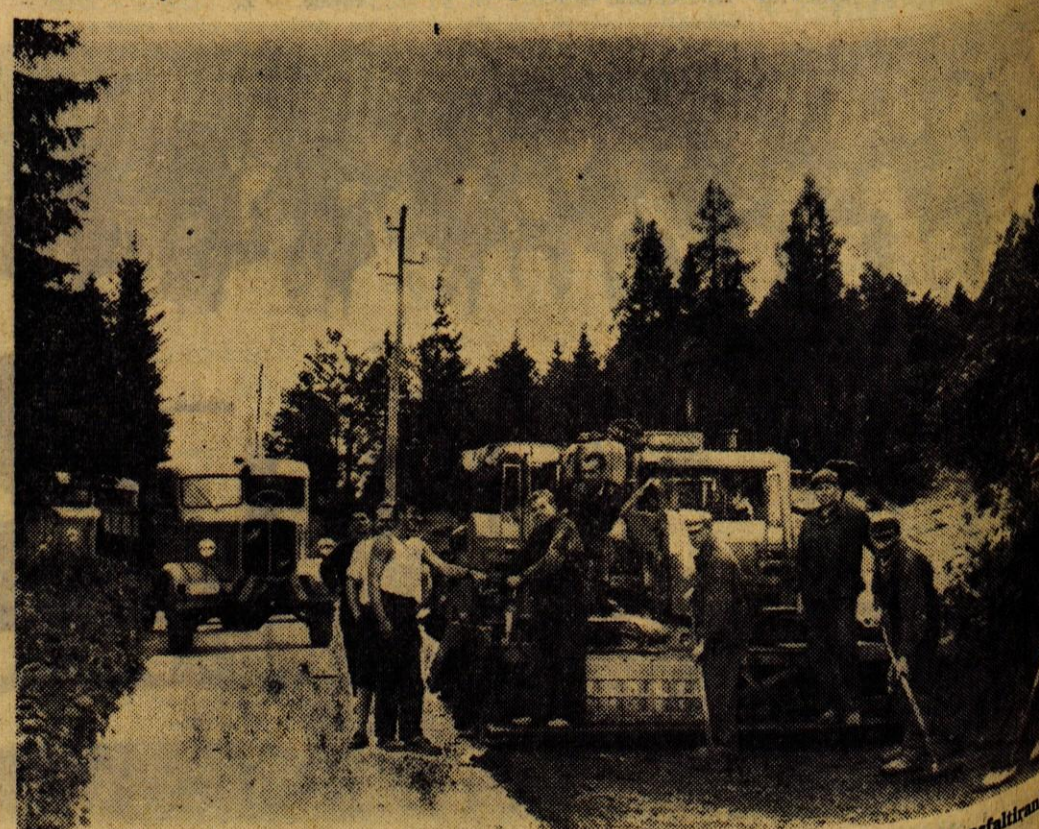
K številnim letošnjim rekonstrukcijam gorenjskih cest se je v ponedeljek priključilo še asfaltiranje ceste na Vršč.
