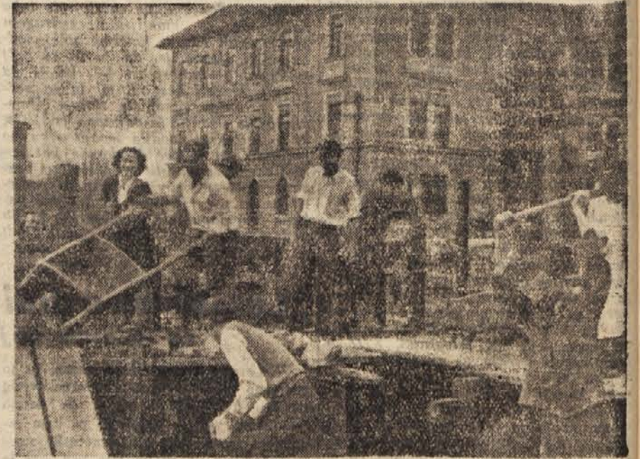
Prostovoljno delo članov stomatološke klinike in zobotehnične srednje šole pri betoniranju temeljev nove stomatološke klinike
