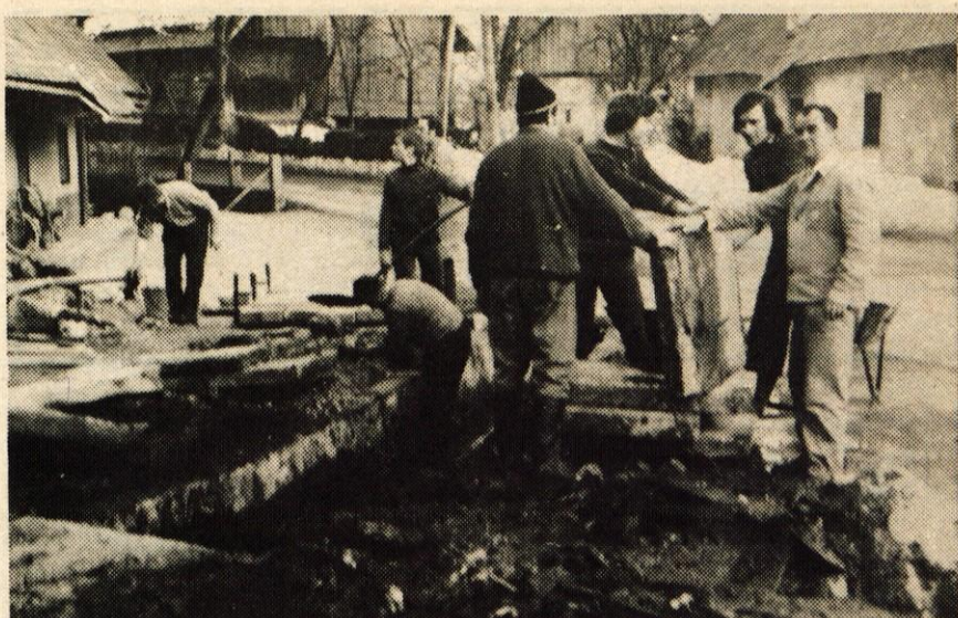
Gasilci iz Smokuč so zelo prizadevni in delavni. Pred kratkim so skozi vas obnovili kanalizacijo, pripravljajo pa se, da bodo odpravili devet divjih smetišč na svojem področju. — Foto: B. B.
