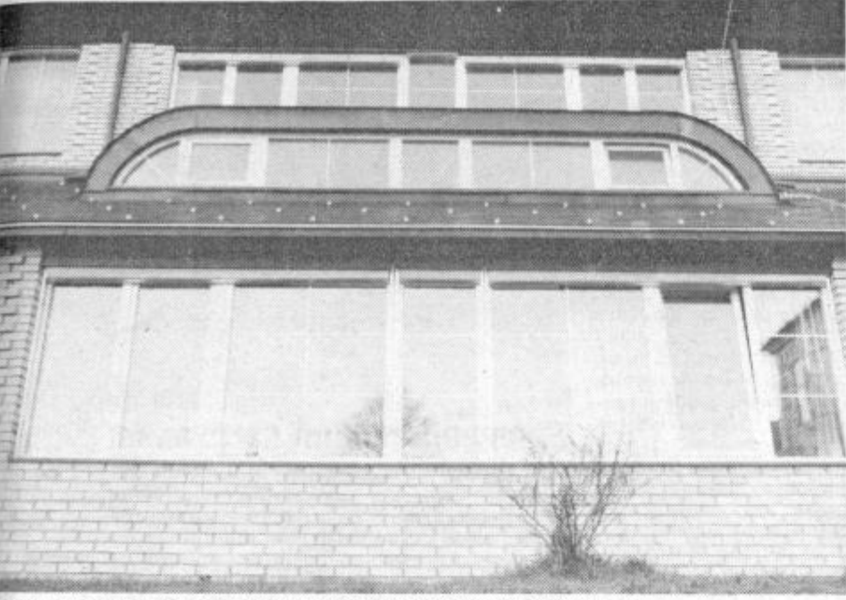
PVC okna vgrajena v šoli Edvard Kardelj v Slovenskih Konjicah.
