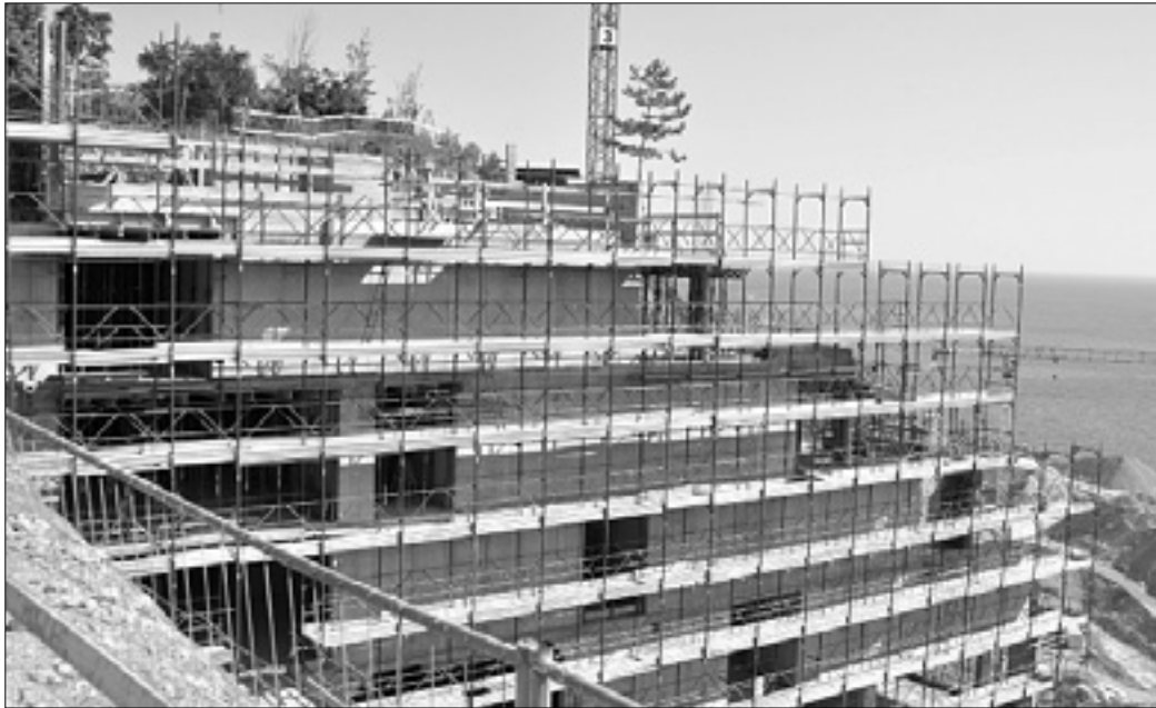
Gradbišče projekta Portopiccino v Sesljskem zalivu, ki je predmet polemik in razhajanj
