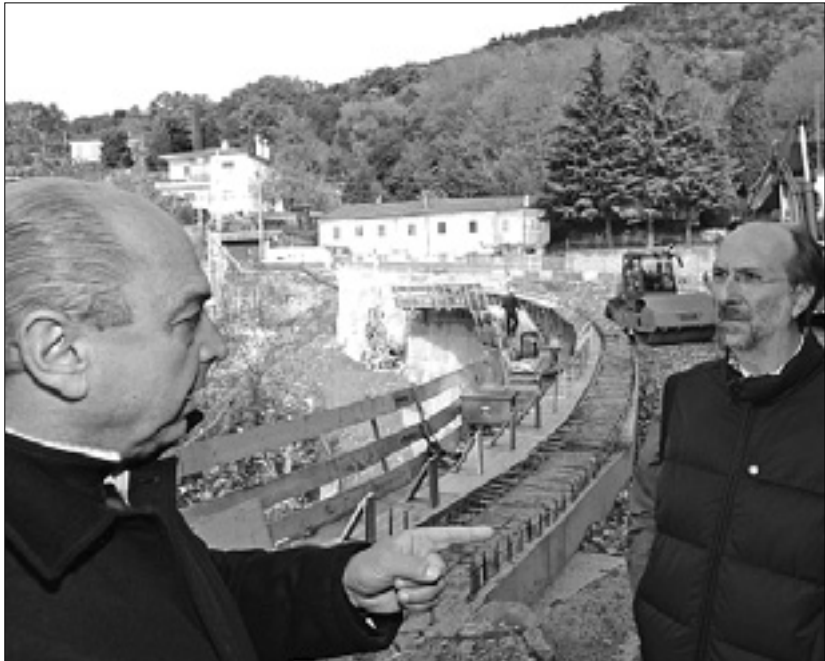
Dipiazza in Riccardi sta si ogledala gradbišče na Furlanski cesti
