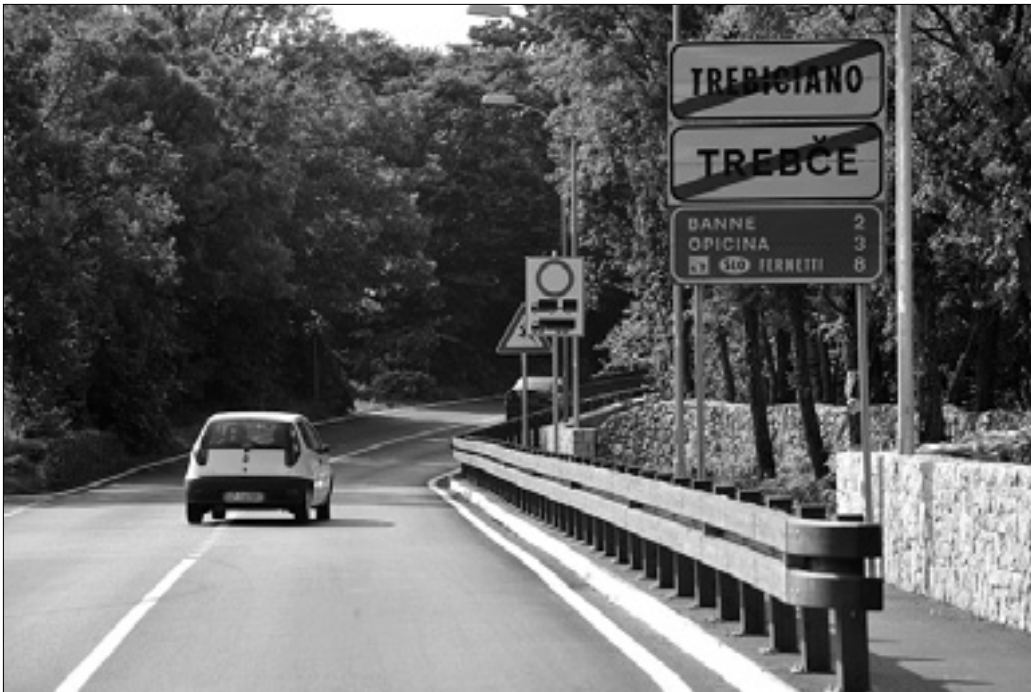
Nov pločnik na odseku ceste od Trebč do pokopališča
