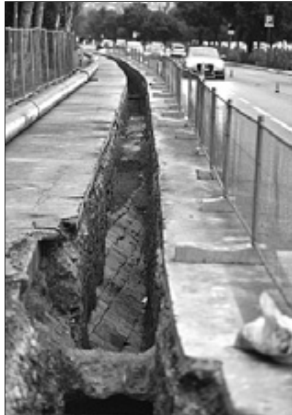
Dela na kanalizacijskih ceveh in pogled na kopališče Topolini ravno na območju čistilne naprave v Barkovljah
