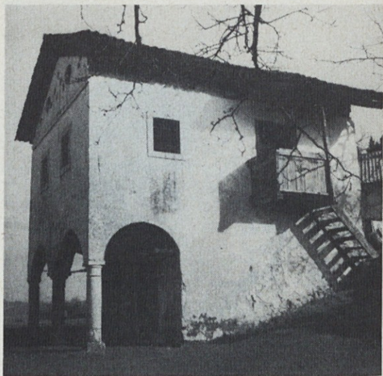
KALCE blizu Logatca; zanimiva gradnja hiše s prednjim delom na stebrih.
