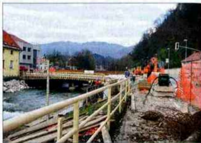
Gradnja mostu poteka po načrtih.
