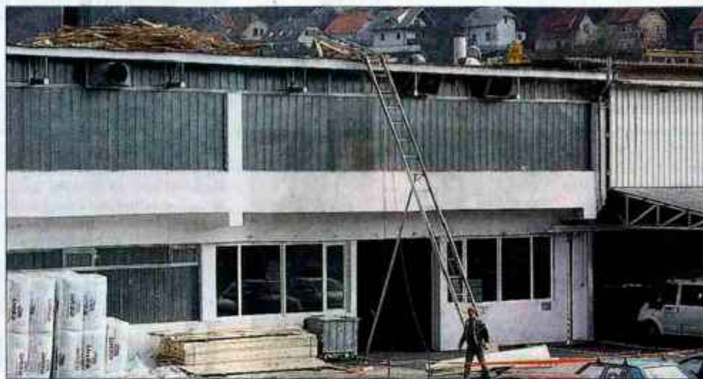
Streho na delu starejše stavbe podjetja Cablex so popravljali ves teden.
