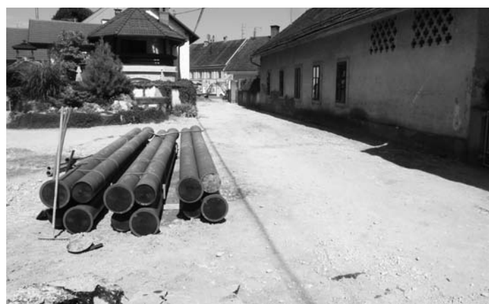
Gradbišče na šolski ulici
