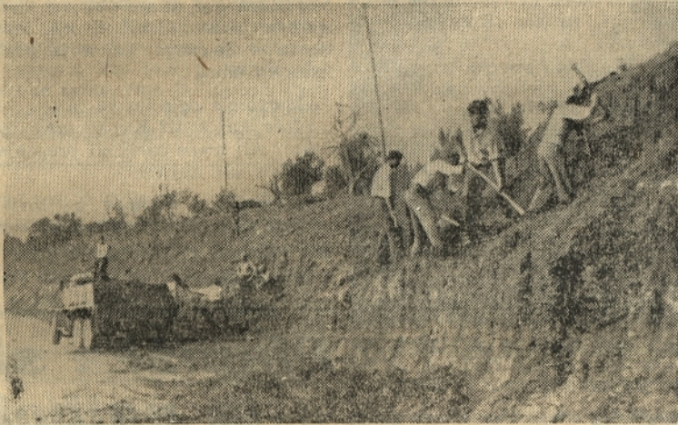
Frontni brigadirji pri gradnji ceste
