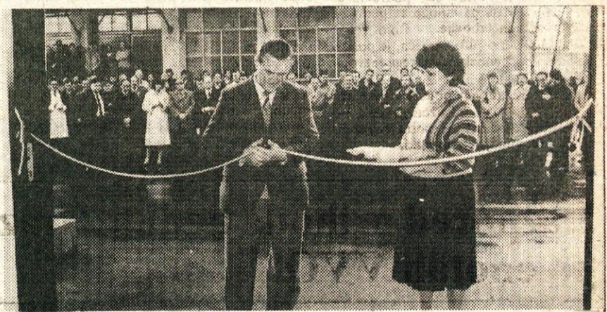
Objekt je odprl eden izmed delavcev z najdaljšim delovnim stažem v TOZD Invest Servis Peter Korošec.
