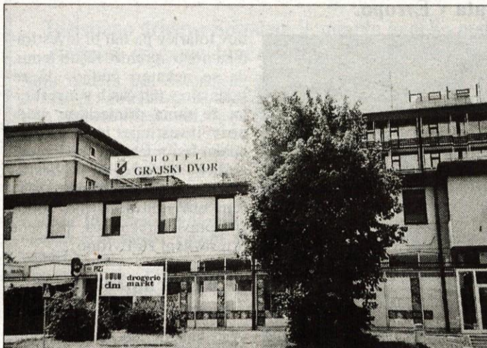
Stari del hotela Grajski dvor je bil zgrajen leta 1939 in delno obnovljen leta 1984. Novi del pa je bil zgrajen leta 1971 in delno obnovljen leta 1985.
