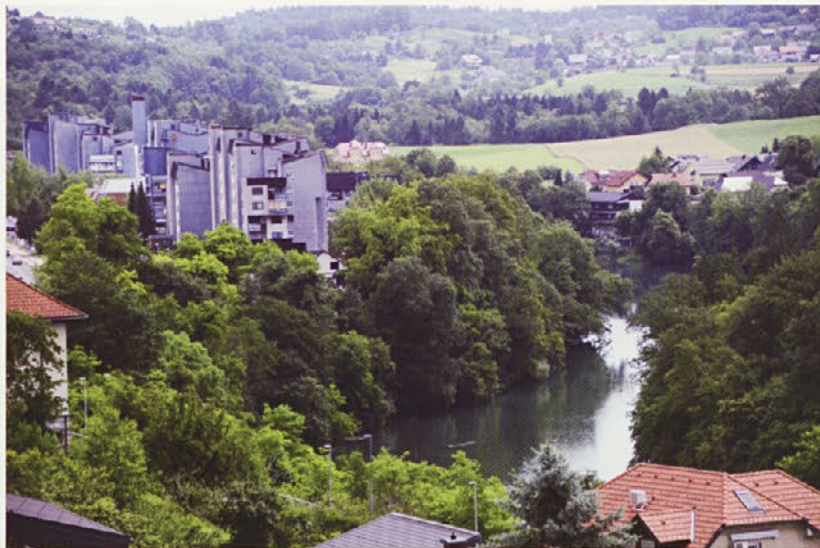
Soseska ob Seidlovi cesti (Plava laguna) je bila ena prvih slovenskih sosesk, zgrajena na podlagi rešitve, pridobljene z javnim natečajem – avtorja Miha Kos in Marjan Cerar (foto: Andrej Hudoklin).
