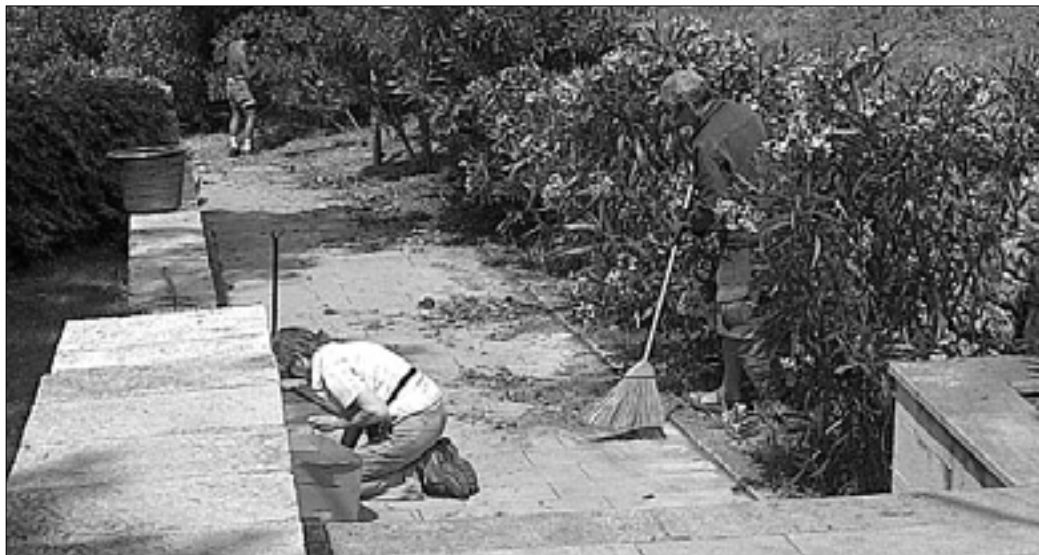
Devinski jesarji čistijo pot, ki povezuje Devin s krajevnim portičem
