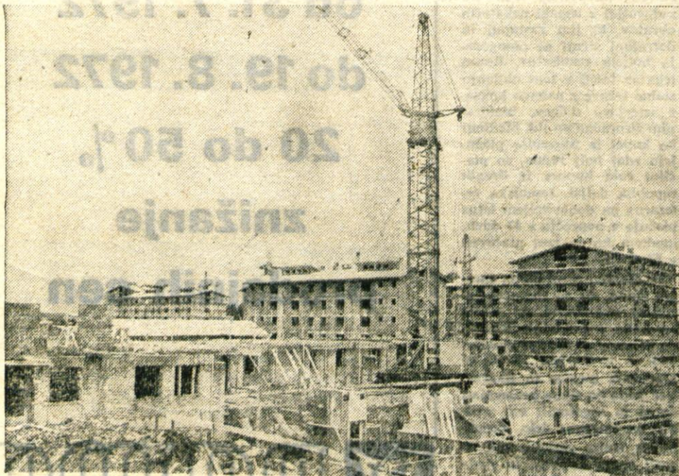
Gradbinci pospešeno gradijo na Planini pri Kranju prvo fazo novega stanovanjskega naselja. V njem bodo prevladovala družinska stanovanja in stanovanja za upokojence. (Jk) — Foto: F. Perdan
