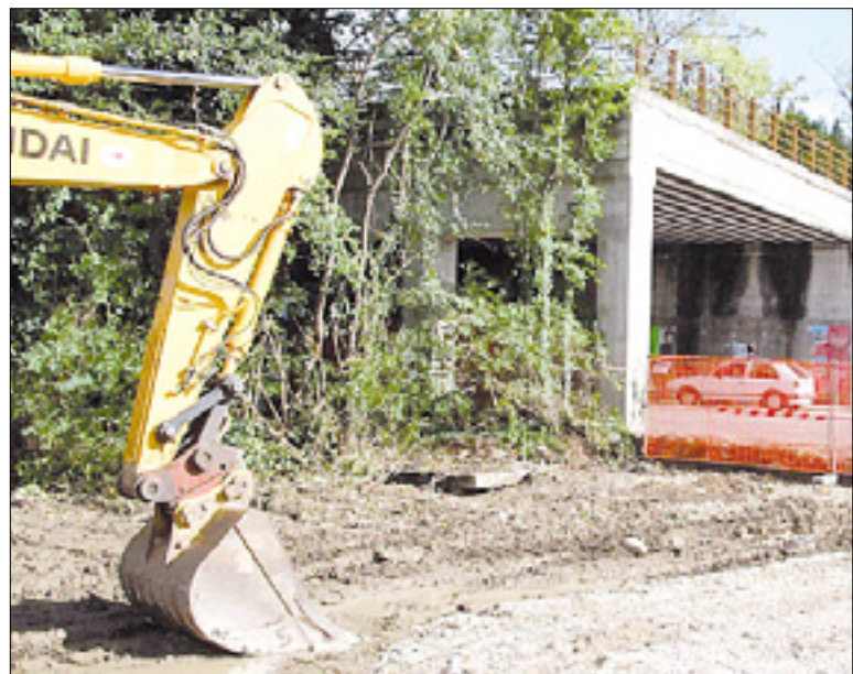
Nadvoz rušijo le z mehanskimi napravami
