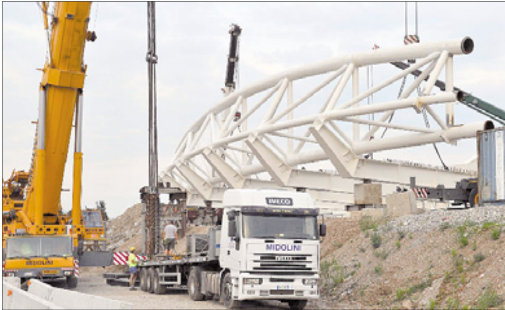
Priprave na nameščanje (levo); jekleno ogrodje so na betonske temelje položili ponoči (spodaj)
