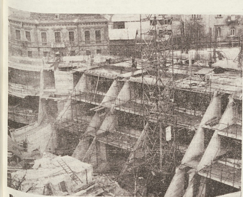
Pogled na že dograjene etaže vrta
