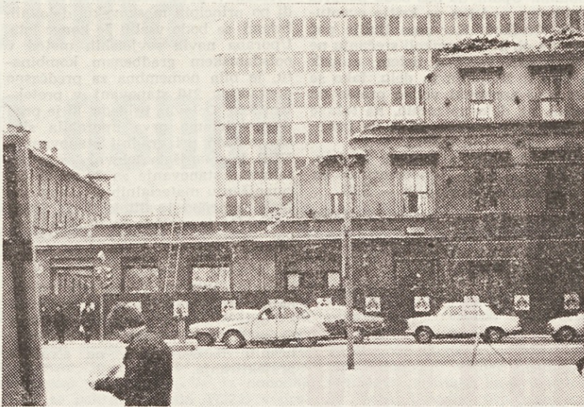
Stare zgradbe se v Ljubljani umakajo novim. Naši delavci rušijo staro »Metalko«
