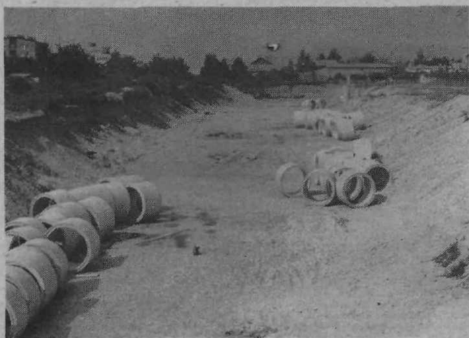
10-LETNI PROGRAM IZGRADNJE CEST
