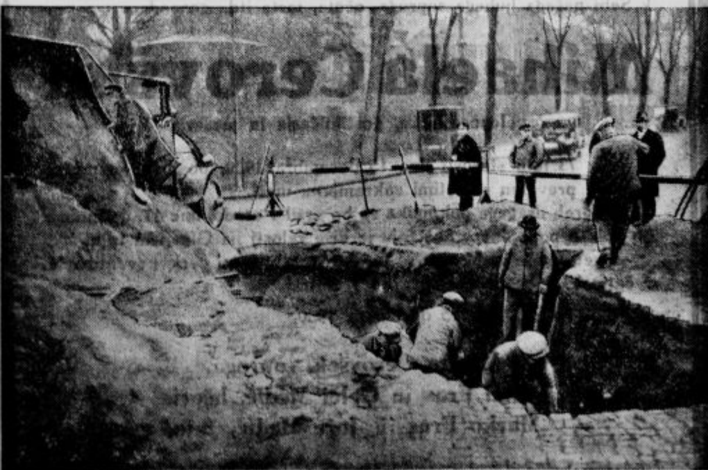
V Berlinu se je vdrla cesta. V kraljevem drevoredu v Berlinu je počila vodovodna cev. Ker tega niso pravočasno opazili, je voda tako izpodkopala cesto, da sta se vdrla dva avtomobila. Tovarni in osebnosti sreči človeških žrtve ni bila.
